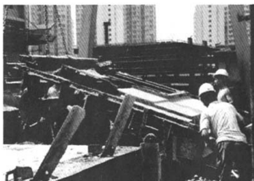
图 1i 钢模水平复位
