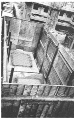
图 1f 在蒸汽箱内养护
