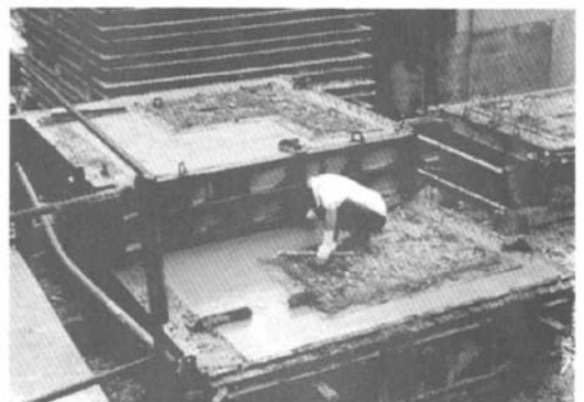
图 1d 楼面板表面修正
