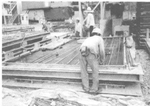
图 1b 在钢模内绑扎钢筋
