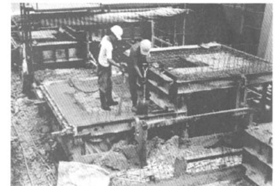
图 1c 浇注混凝土并振动
