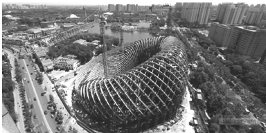
图3 北京凤凰国际中心施工实景
