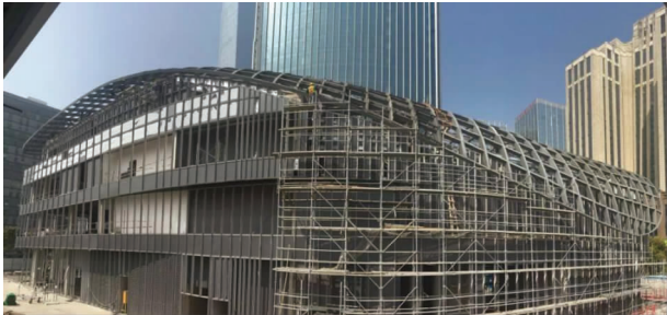
图 5 曲面支撑的钢结构
