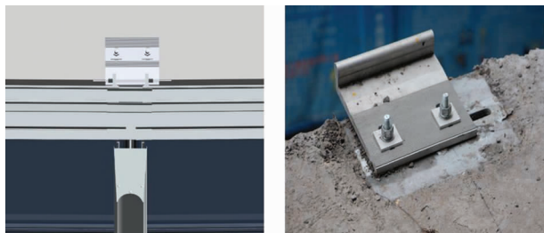
图 36 埋件安装工艺指导与现场效果
