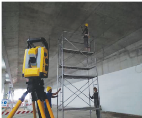
图 22 放样机器人现场定位
