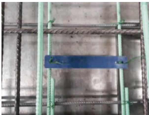
图 2 RFID 标签绑扎安装法
