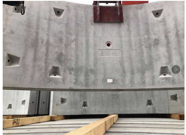
图 4 地铁管片转运到堆场
