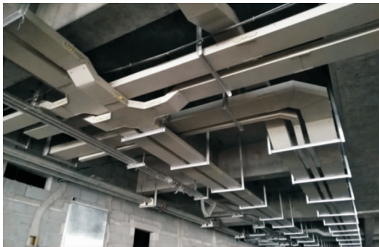
图 5 深化后的施工
