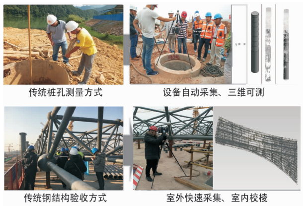
图 13 三维激光扫描仪作业及成果
