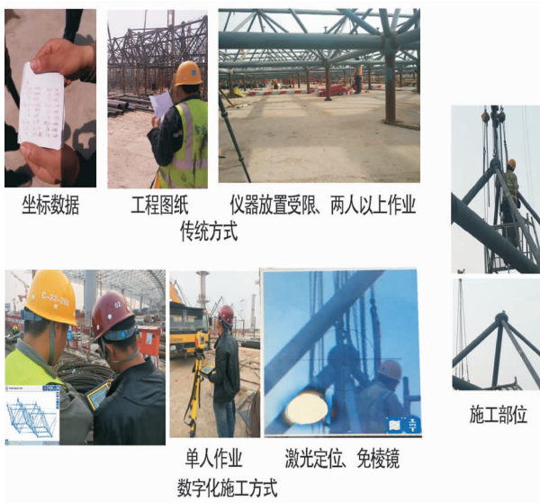
图 12 BIM 放样机器人与传统测设对比
