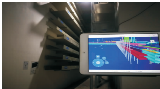
图 9 模型校核现场施工状况
