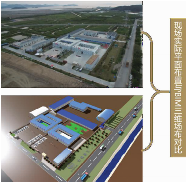
图 7 现场实际场布与 BIM 三维场布对比
