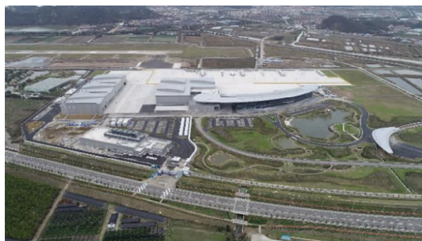
图 21 工程航拍进度照片——拍摄于 2019 年 3 月 25 日
