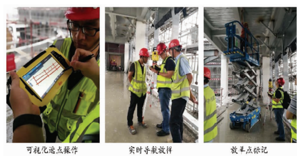
图 17 智能放样机器人操作实施
