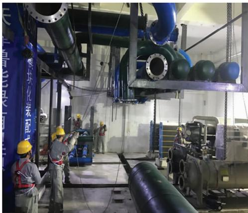
图 10 模块现场组对安装
