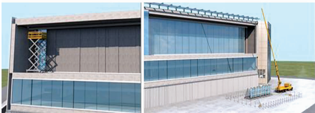
图 9 外幕墙超透大玻璃安装工艺模拟图
