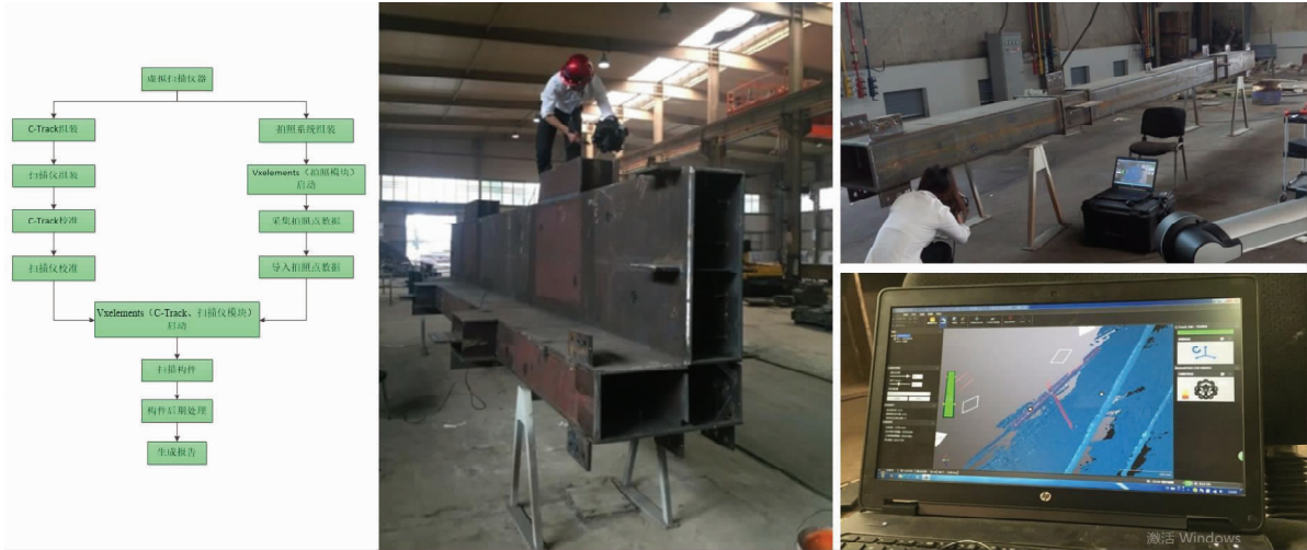
图 20 钢结构工厂预拼装
