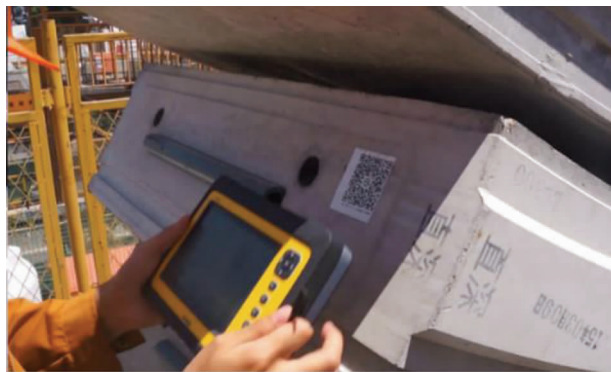
图 14 现场二维码应用情况
